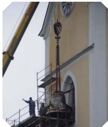
Die neuen Glocken wurden von einem Spezialkran in die Höhe gebracht und mit Hilfe eines Kettenzuges (5 t Tragkraft) in den Glockenturm hineingezogen.
